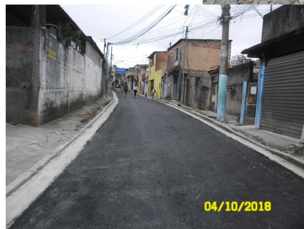
Pavimentação da Rua Pilbarra
