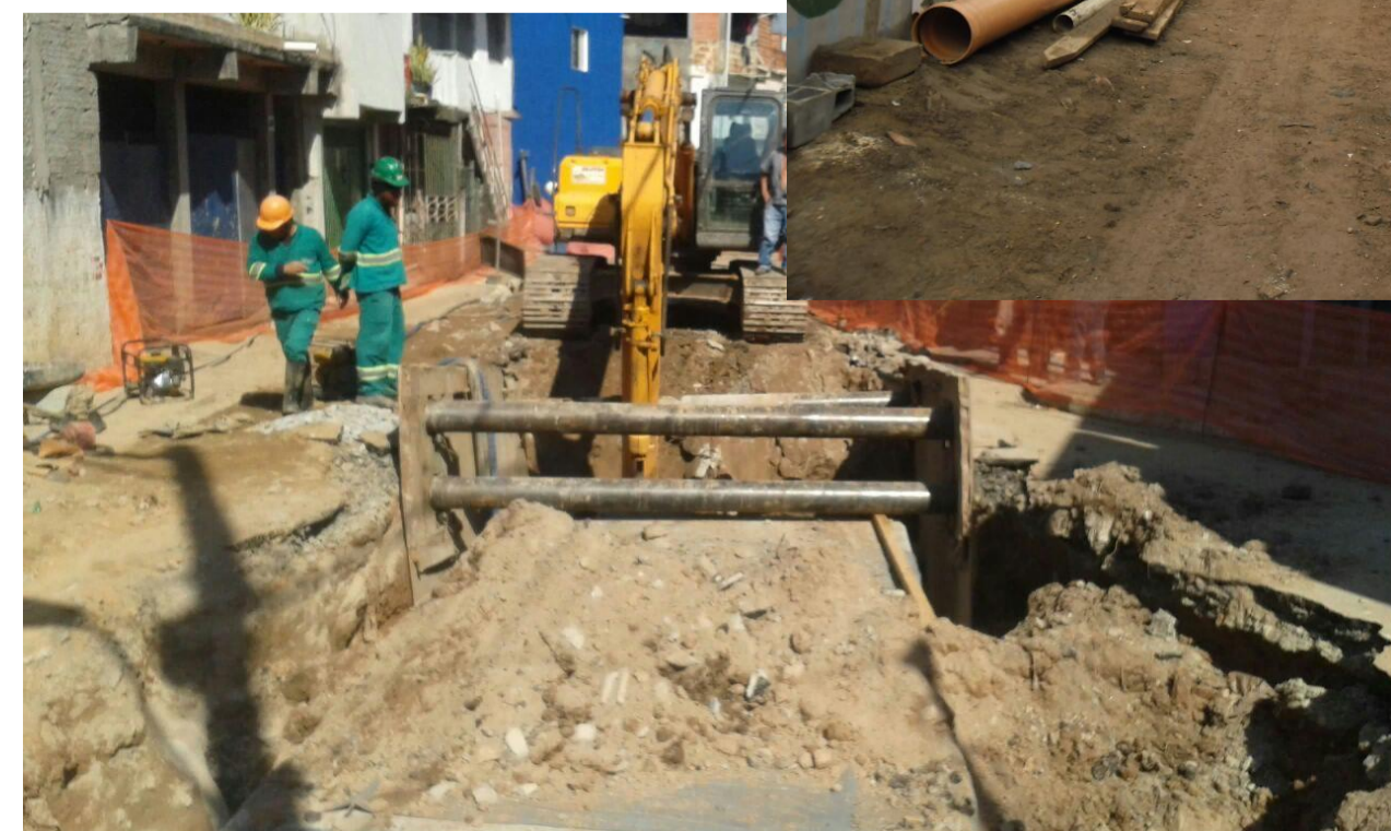
Canalização e pavimentação da Rua Projetada
