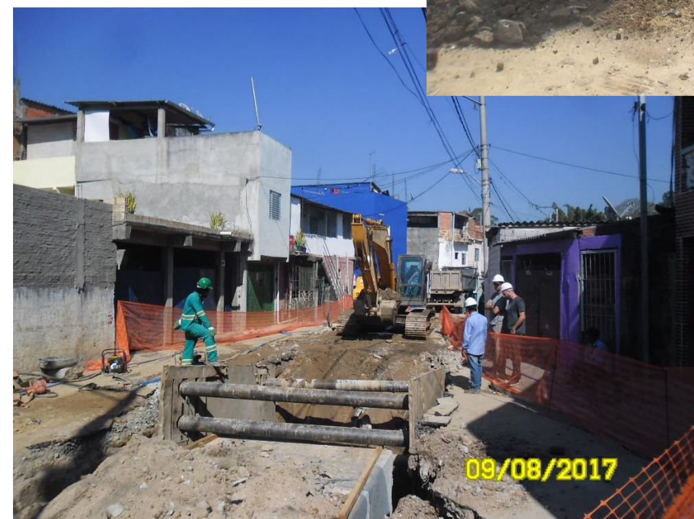
Canalização de córrego e recomposição de pavimento da Rua Talamanca
