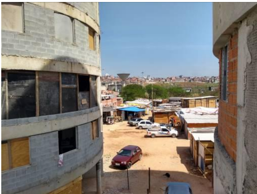
Foto 4 – Vista geral da ocupação do primeiro andar de um dos blocos
